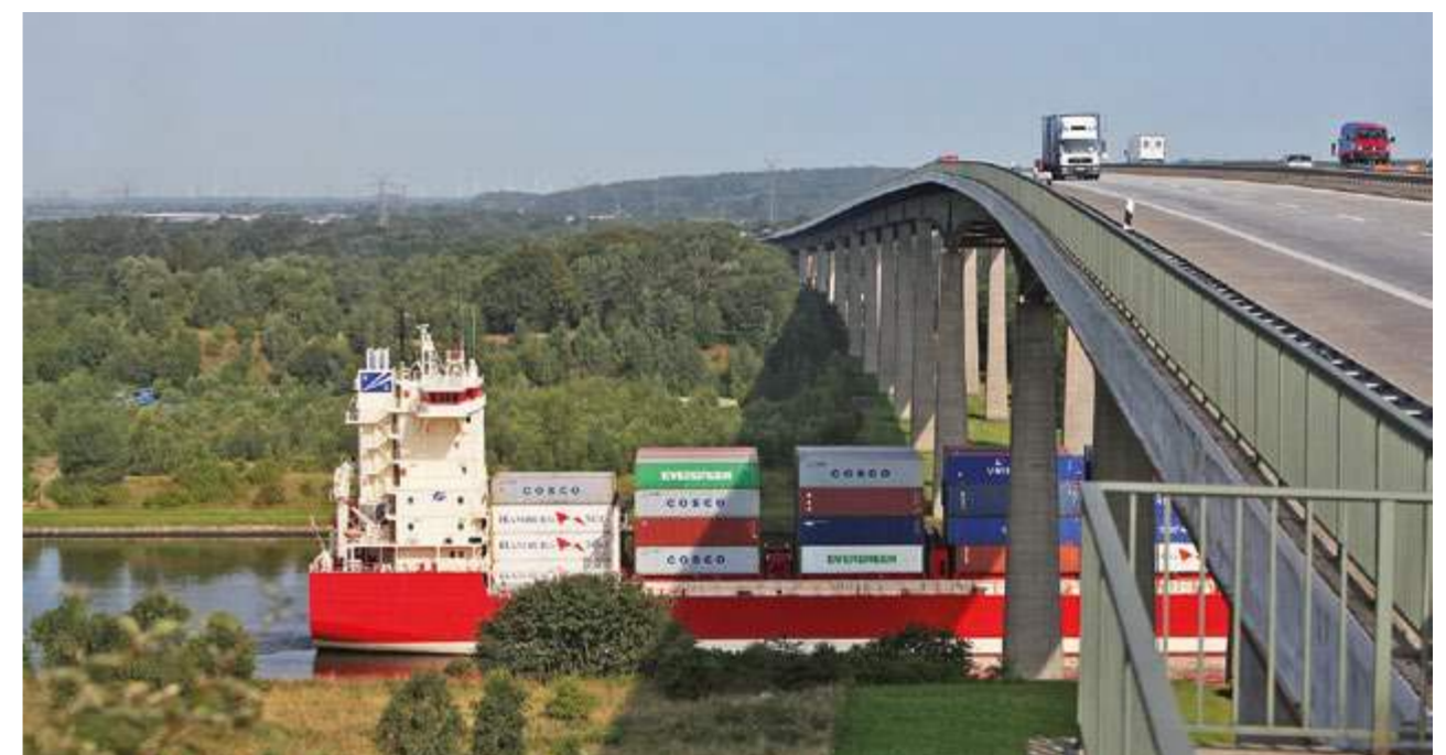
BESTANDSBAUWERK DER RADER HOCHBRÜCKE.
