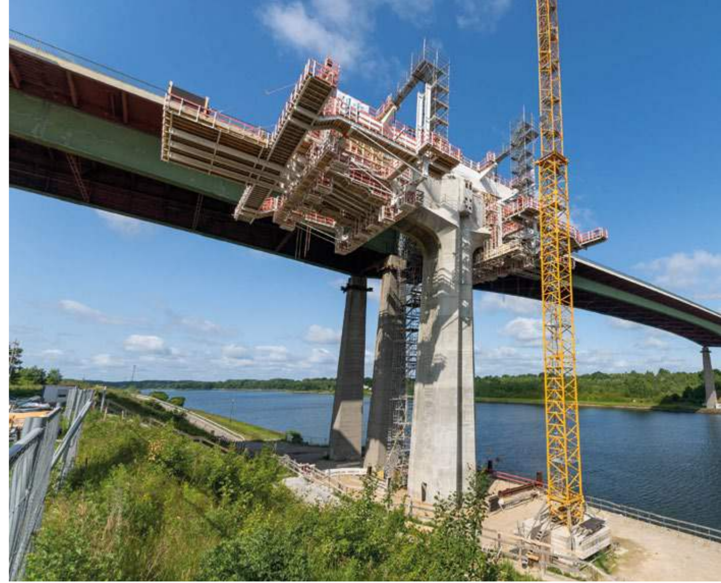
FREIVORBAU SÜDLICHER HYBRIDPFEILER.
