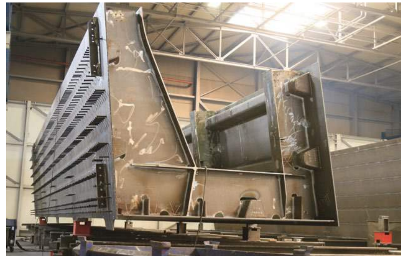
STAHLBAUFERTIGUNG IM WERK.
