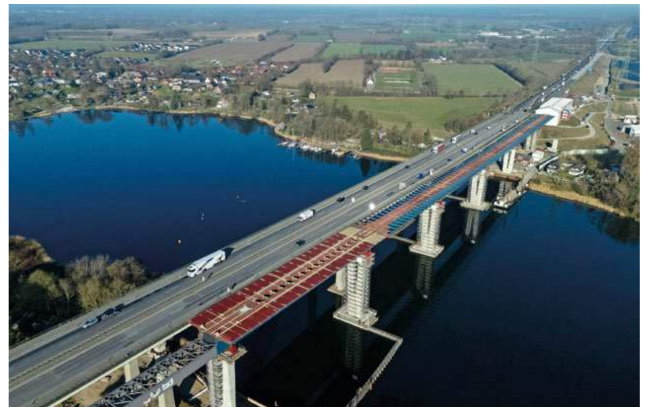
BAUTENSTAND APRIL 2025, TAKTSCHIEBEN VON NORDEN.
